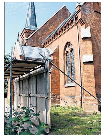
An der Südseite des Chores schützt ein Gerüst Fußgänger.
